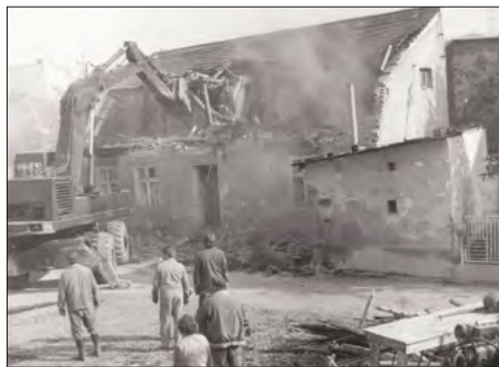
Demolice již neobydleného domu paní Liebnerové 1989
